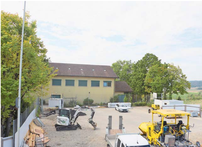
Die alte Turnhalle (links) steht kurz vor dem Abbruch. Ist sie verschwunden, öffnet sich vom Schulareal der Blick hinaus in die Landschaft. Im Neubau mit seinem auffälligen grünen Hallenboden (rechts) ist derweil bereits Alltag eingelebt. Bilder: st
