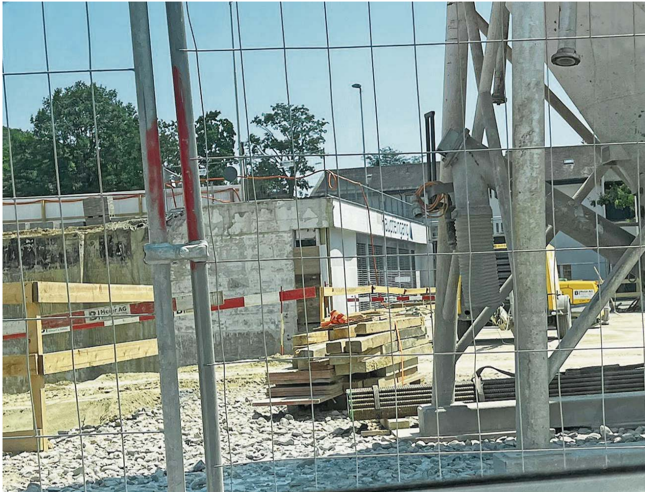
Die Arbeiten rund um die neue Turnhalle laufen auf Hochtouren. Der Aushub ist bereits abgeschlossen.
