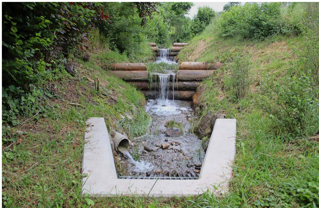
Der sanierte offen geführte Mühlbach und der erneuerte Einlauf in den Dorfbach haben sich bewährt.
