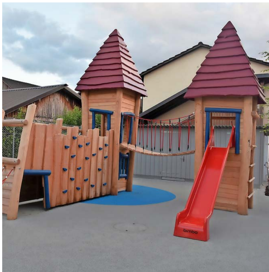
Im Frühling hat der Umbau im Kindergarten Wil begonnen, und die ersten Spielgeräte sind bereits installiert.
